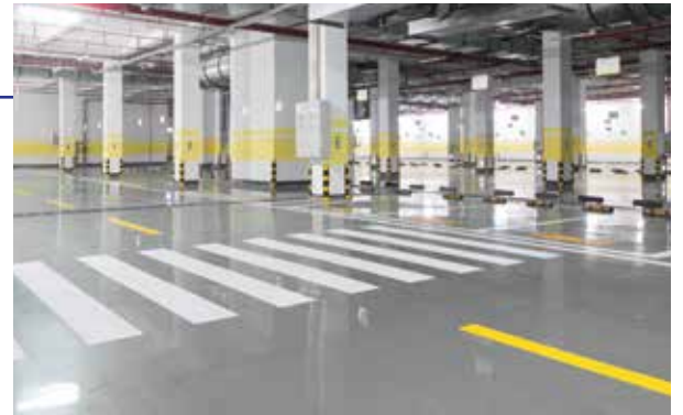
Demarcación de pisos en áreas de proceso, pisos en general y parqueaderos.
