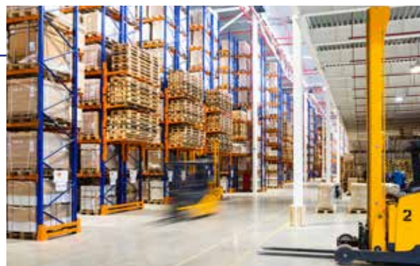
Muros, pisos y equipos en áreas de almacenamiento.
