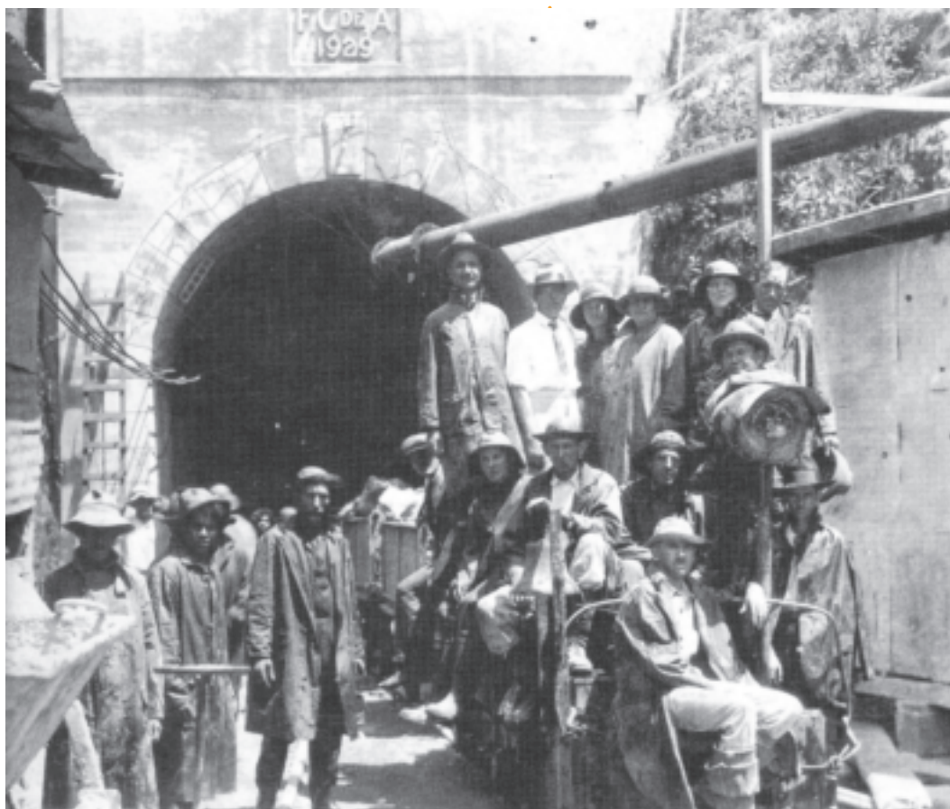
Túnel de la Quebra
